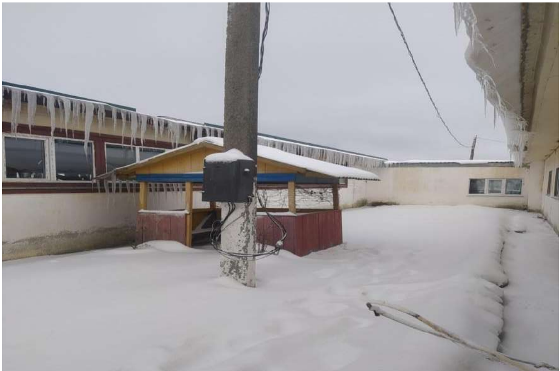
Электроустановка находится на опоре линии электропередач в технически неисправном состоянии (токоведущие части доступны для случайного прикосновения).
