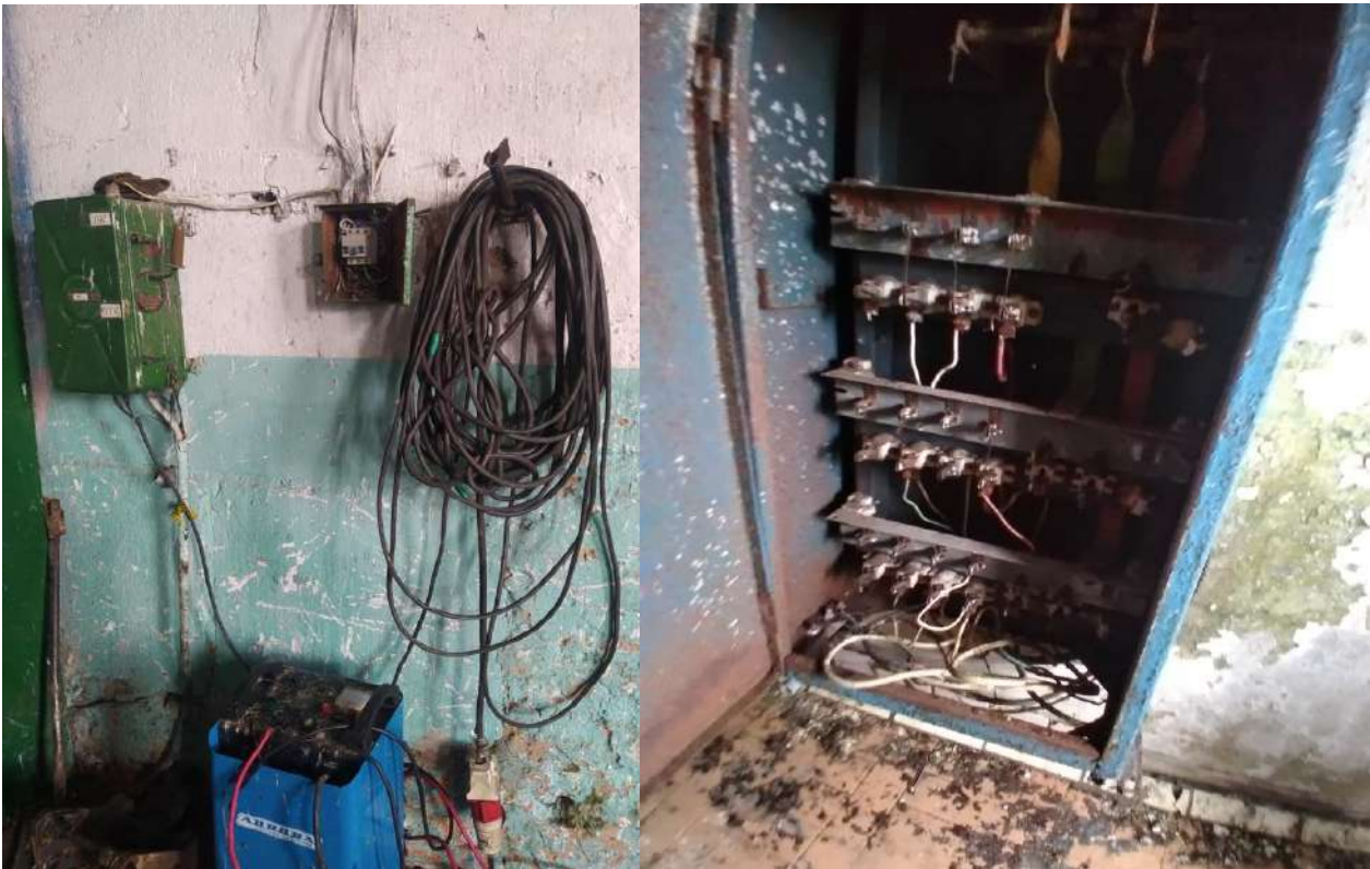
Не обеспечены безопасные условия труда (распределительный щит не закрыт на запирающее устройство).
