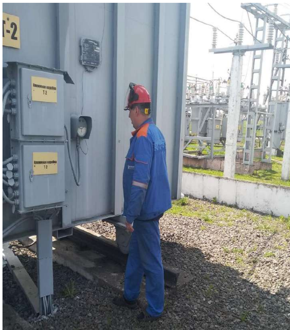
Выполнение работ без применения специальной обуви.
