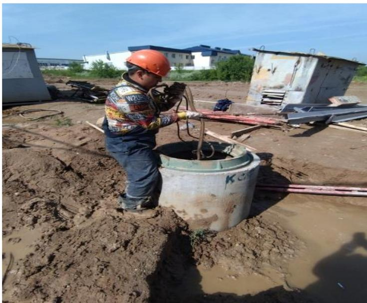
*При выполнении работ в емкостном сооружении использовался светильник напряжением выше 12 В, провод удлинителя для подключения электрического светильника не был защищен от случайного механического повреждения, был натянут и перекручен*
