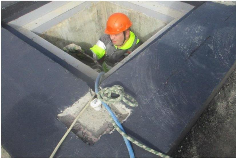
*Работы проводятся в колодце глубиной более 1м, при этом ограждение открытого люка подземного емкостного сооружения в местах движения людей выполнено не было. Кроме того, в месте производства работ вентилятор, газоанализатор для проведения периодического проветривания и проверки воздушной среды емкостного сооружения отсутствовали. До спуска в колодец воздушная среда с помощью газоанализатора на предмет наличия вредных и взрывоопасных веществ, содержания кислорода исследована не была*
