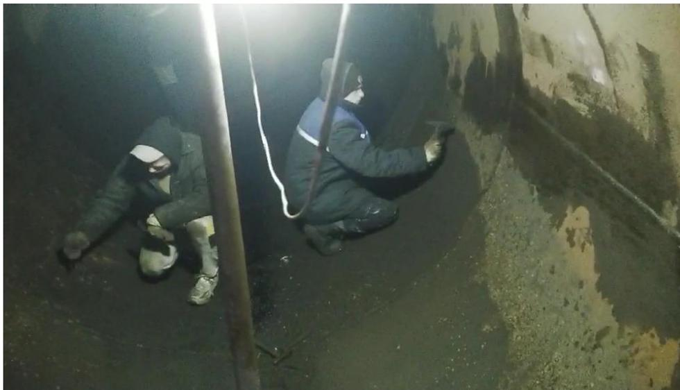
*Работники, выполняющие работы в емкостном сооружении, не обеспечены защитными касками, предохранительными ляжечными поясами (страховочными привязями) с прикрепленными к ним страховочными канатами (веревками) и средствами индивидуальной защиты органов дыхания (шланговыми или изолирующими противогазами (дыхательными аппаратами))*
